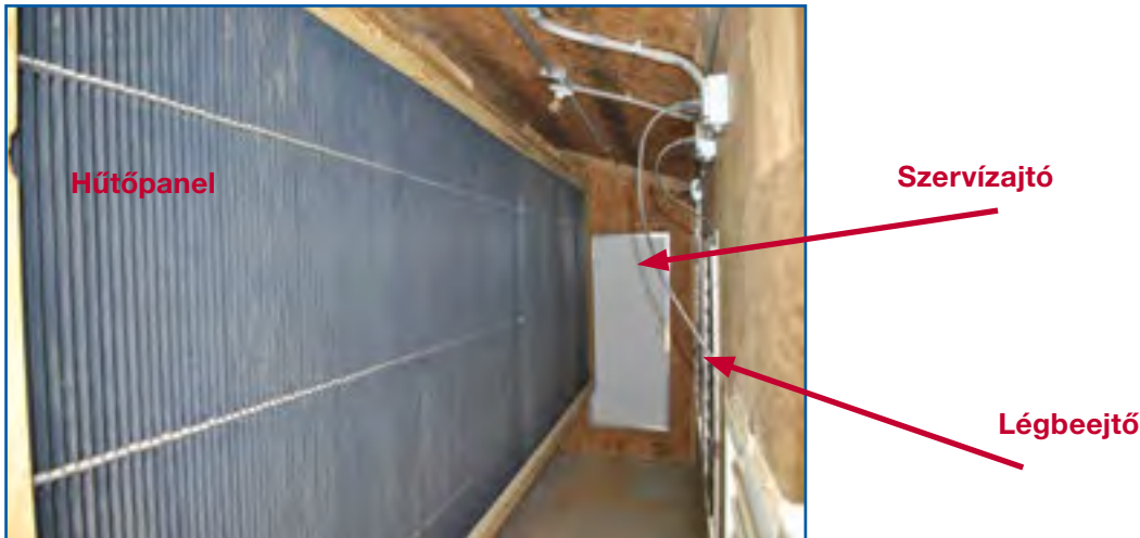
6.20 ábra: Példa az istálló oldalfalán a „kis házban” felszerelt hűtőpanelre
