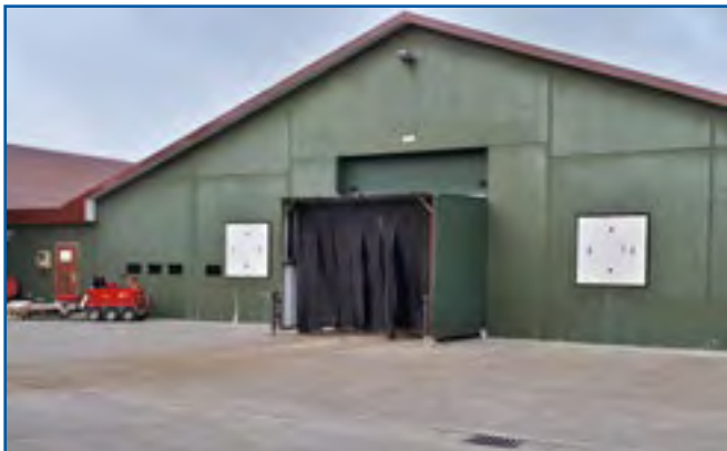
8.1 ábra: Fügöny használatával történő fénycsökkentés, nappali rakodáskor
