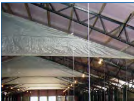
6.14 ábra: Légtelők/terelőfalak elhelyezése alagútszellőztetéses istállóban
