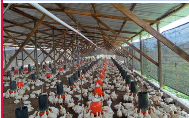
Figura 6.4 Exemplo de um galpão aberto.
