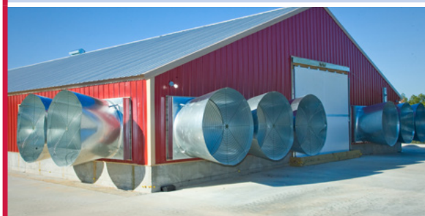
Figura 6.17 Exemplo de um galpão típico com ventilação em túnel.
