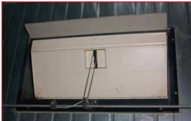
Рис. 6.9: Пример приточной форточки высокого качества
