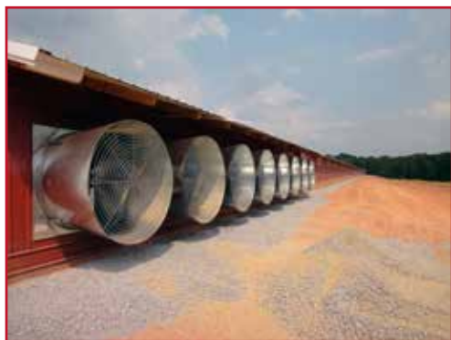
Рис. 6.13: Пример птичника, оборудованного туннельной вентиляцией
